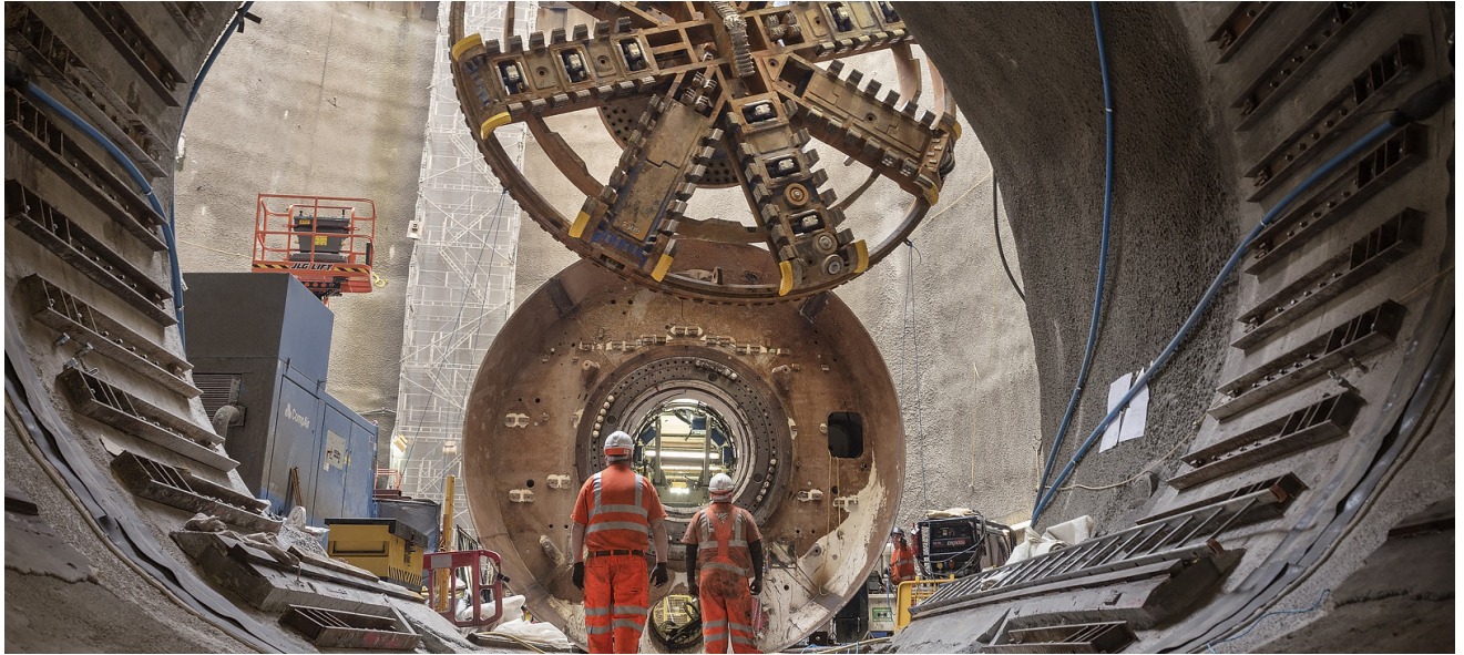
Das Schneidrad wird per Kran 45 m in die Tiefe gehoben und dann mit Manpower millimetergenau angepasst.
